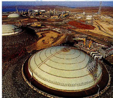
LNGの貯蔵タンク
