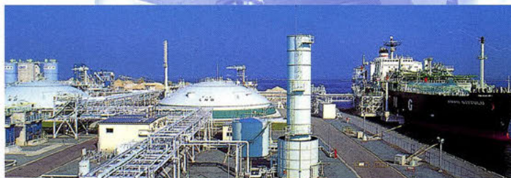
LNG受入基地
